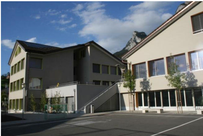
Abb. 7: Das renovierte Schulhaus Mythen 2011.
