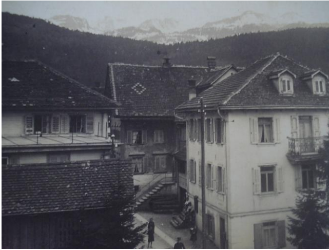
Abb. 11: Vorne im hellen Gebäude war die Post bis 1948 (Gruss aus Schwyz).
